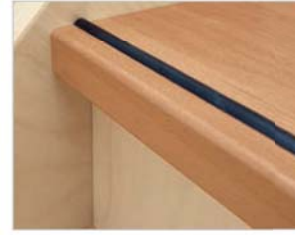
Treppenstufen: massives, abriebsfestes Hartholz mit Antirutschkante -> stabil und trittsicher
